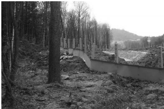
图4 两栖类动物通道隔离栅现场实景图
